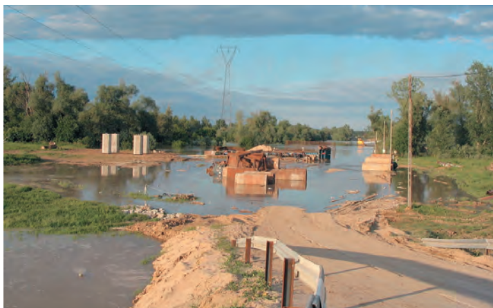
Wylew Wisły podczas budowy nowego mostu, 7 czerwca 2006 r.
