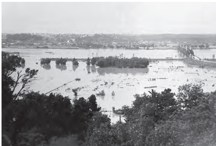
Ogromny wylew Wisły pod Puławami, 1934 r.
